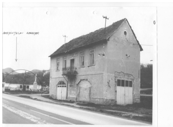
Stari (sada srušeni) vatrogasni dom u Ul.S.Radića
